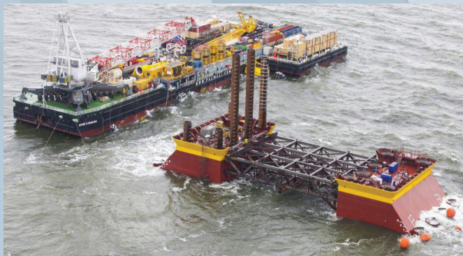
Забивка свай опорных блоков центральной технологической платформы. Месторождение им. Филановского, 2015г.
