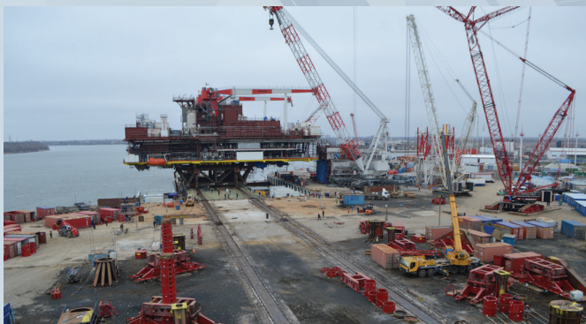
Перемещение по путям МСП на ТМБ (вес 7 135т)
