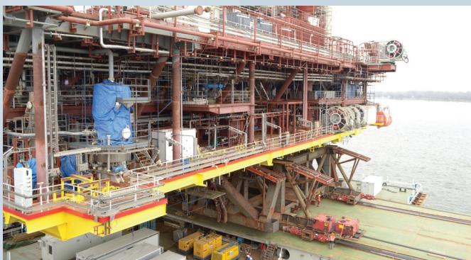
Перемещение верхнего строения ЛСП-2 по путям надвижки на барже п. Ильинка, г. Астрахань, 2017 г.
