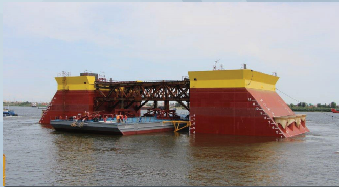
Транспортировка опорных блоков центральной технологической платформы. г. Астрахань, 2015г.
